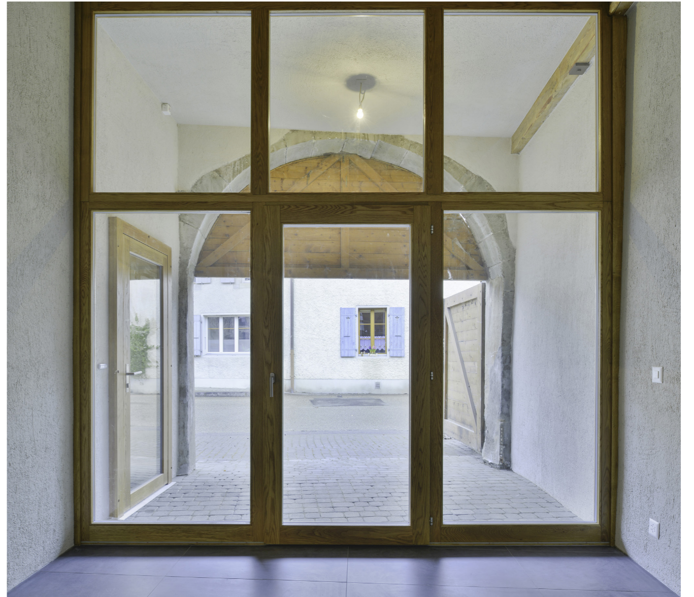
menuiseries extérieures (avant pose des lames extérieures)
